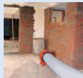
Stemm- und Putzarbeiten
